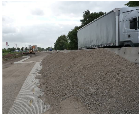
Abb. 6 Aufbau der geokunststoffbewehrten Tragschicht neben der Bestandsfahrbahn
