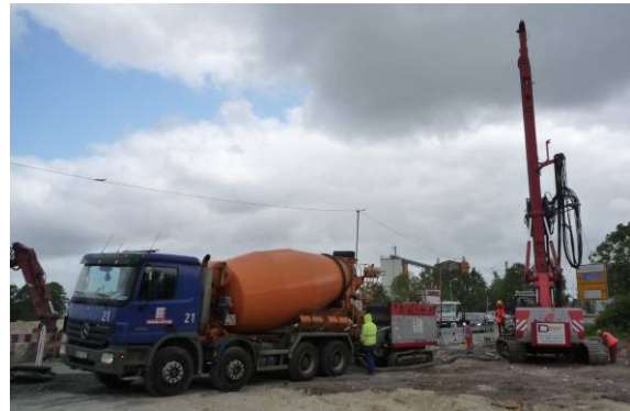
Abb. 4 Herstellung der CMC-Säulen (Betonmischer, -pumpe und Fertiger)
